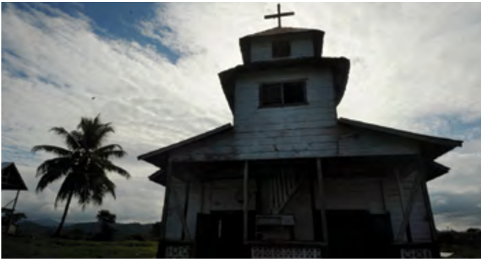
Antes del PODU, sin servicio de energía eléctrica las 24 horas.
